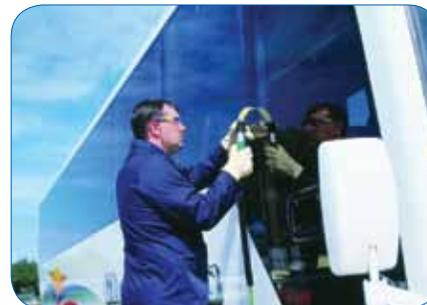
auch für Busse und Schienenfahrzeuge dank unterschiedlicher Klingen ist das BTB Gerät für praktisch alle geklebten Scheiben, Paneele und Zierleisten einsetzbar
